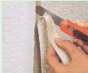
Raufaser um die Ecke kleben und dann genau an der Ecke mit einem Messer abschneiden
