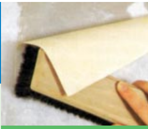
Die erste Bahn an der Markierungslinie anlegen
