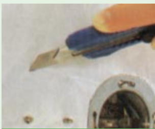
Mit einem Teppichmesser die Steckdosen wieder freilegen und die Abdeckung aufbringen
