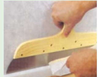
Überstehende Tapete mit einem Spachtel fixieren und dann abreißen
