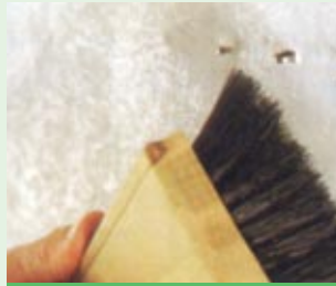
Strom abschalten und Steckdosen nach Entfernen der Abdeckungen übertapezieren
